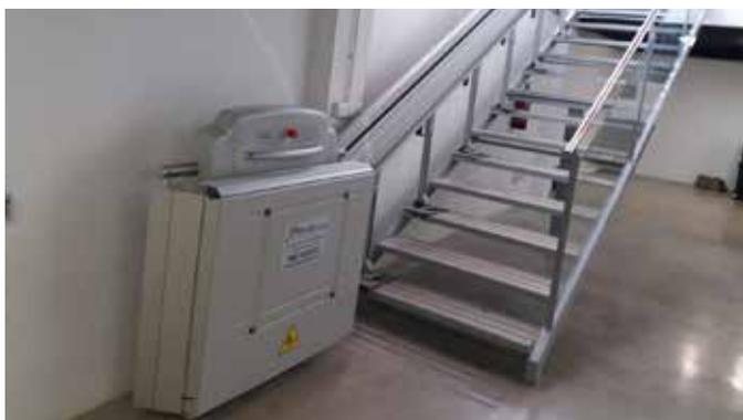
La batería de reserva permite que la PETC-SU funcione en caso de corte de corriente.
